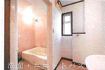
洗面・ユニットバス
